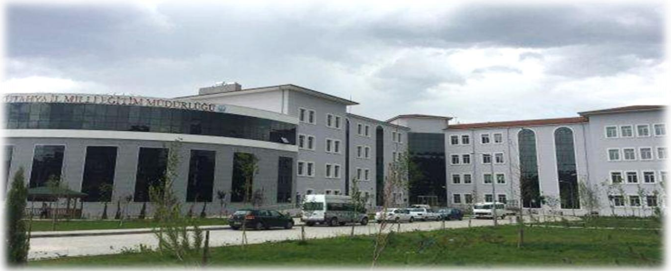
İl Milli Eğitim Müdürlüğü Hizmet Binası
